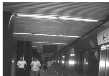
图 2 北京地铁 5 号线车站金属吊顶
