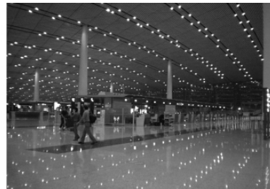
图 1 北京首都国际机场 T3 航站楼金属吊顶
